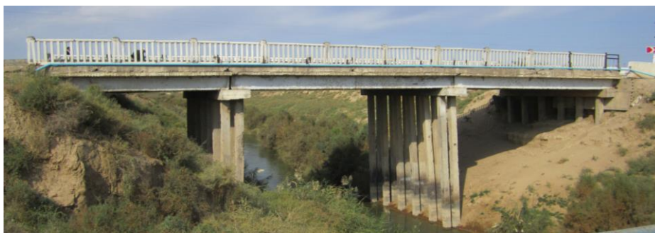
Рис. 1. Общий вид моста
